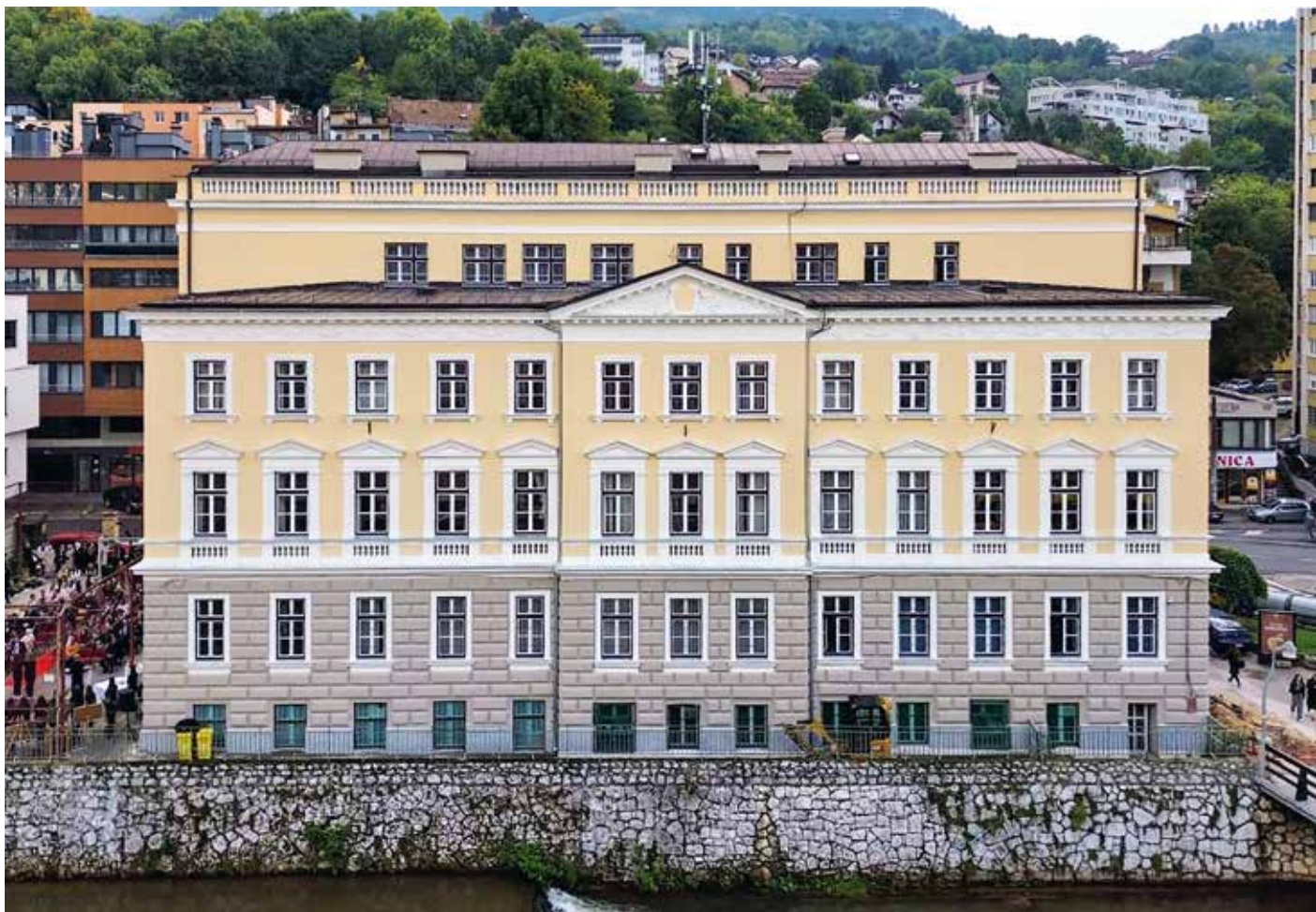
Najveća rekonstrukcija u posljednjim decenijama: energetska obnova zgrade na Drveniji vrijedna 1,9 miliona KM.
