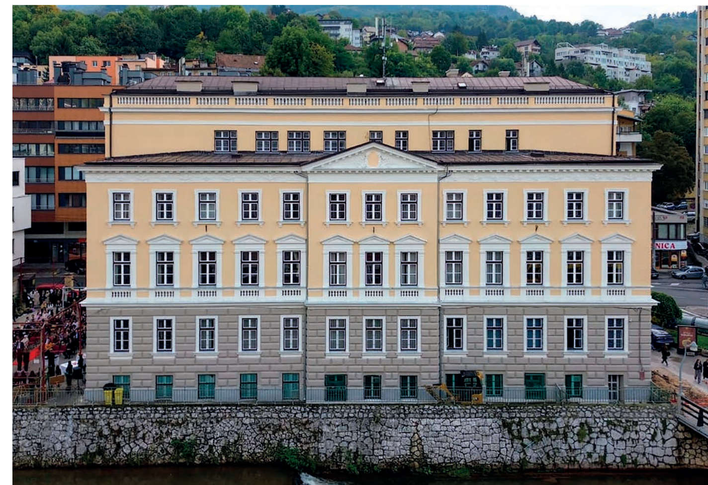
Najveća rekonstrukcija u posljednjim decenijama: energetska obnova zgrade na Drveniji vrijedna 1,9 miliona KM.
